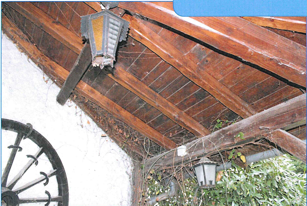
COMPTEURS D'EAU SOUS LE COIN COUVERT
