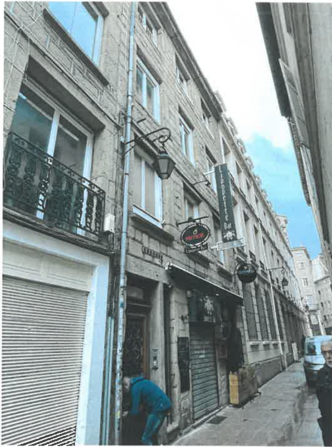
Photo n°2 : vue de la façade.
