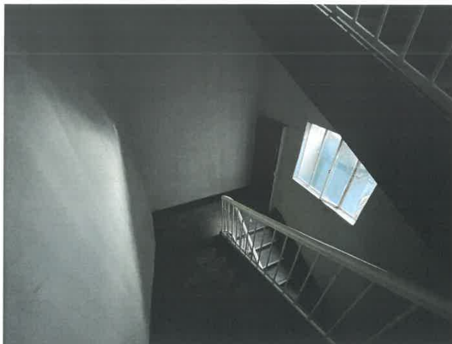
Photo n°3 : vue de la montée d'escaliers.
