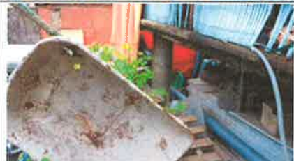
Photo n° PhA002 Localisation : Escalier extérieur Ouvrage : Extérieur Partie d'ouvrage : Plaques (fibres-ciment) Description : Jardinière en amiante ciment Localisation sur croquis : P2
