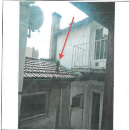
Photo n° PhA001 Localisation : Sdb1 Ouvrage : Conduit de ventilation en fibro-ciment Partie d'ouvrage : Conduit de ventilation en fibro-ciment Description : Conduit de ventilation en fibro-ciment
