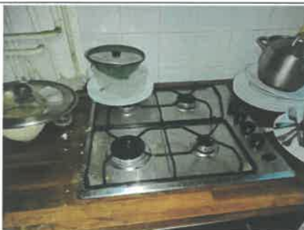
Photo n° PhGaz001 Localisation : Cuisine Table de cuisson ikea (Type : Non raccordé)
