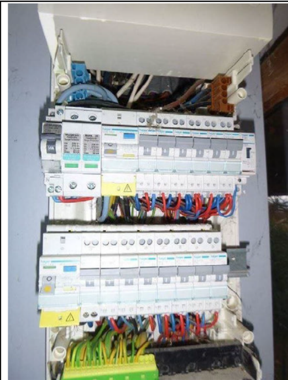
Photo PhEle001 Commentaire : Interrupteurs différentiels 30mA calibrés à 40 A
