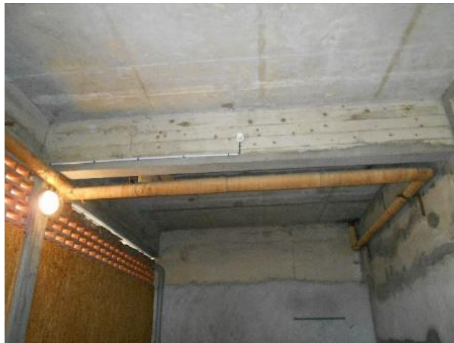
Calorifugeage dans les locaux non-chauffés
