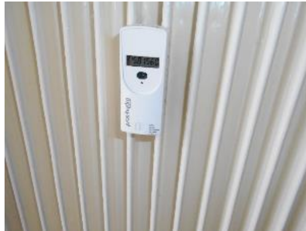
Répartiteur de frais de chauffage
