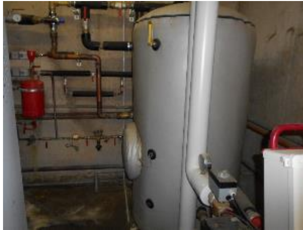
Ballon de stockage ECS 750 litres
