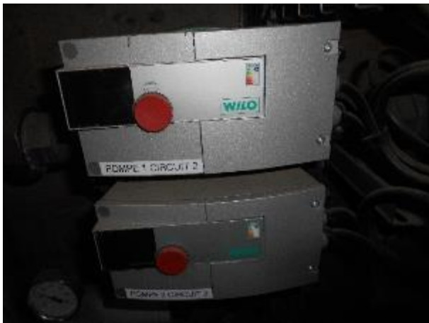
Circulateur à vitesse variable
