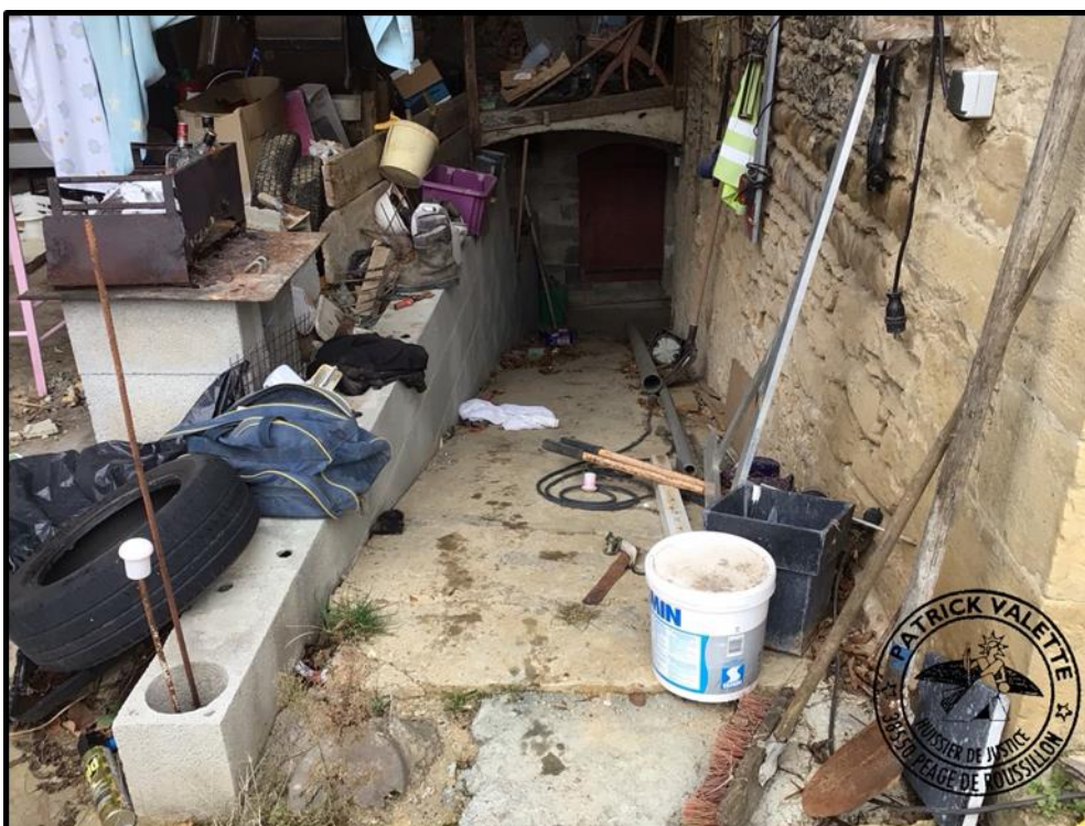
Une descente en béton donne accès à une cave située sous la partie habitation.
